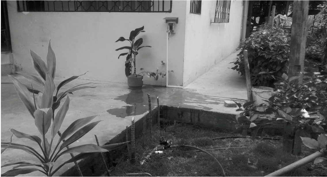
Figura 3. Implementación del control estable y terminado.
